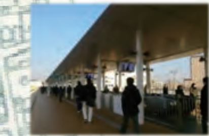
動く歩道（トラベレータ）長い駅間を快適に移動（写真例 海老名駅周辺の空中歩廊）
